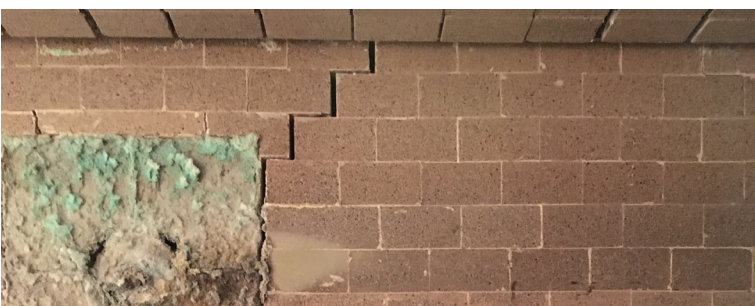
Korrodierte Wand und Treppenrisse
