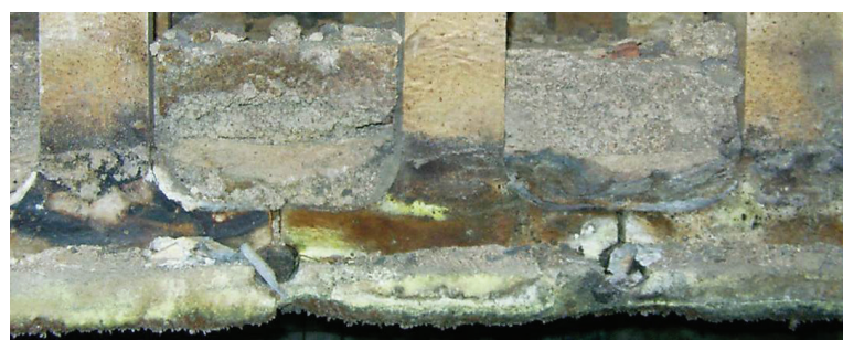
Korrodierte Hängedecke durch Alkaliangriff
