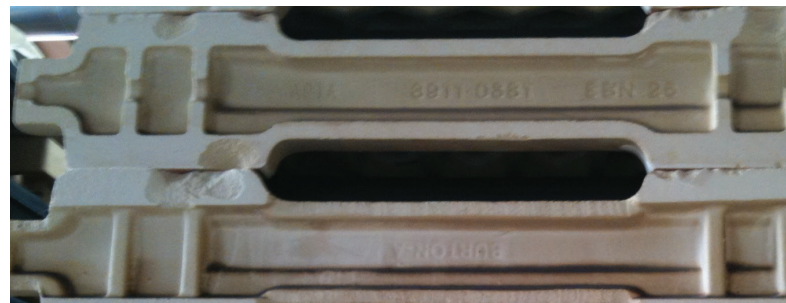
Abplatzungen an H-Kassetten
