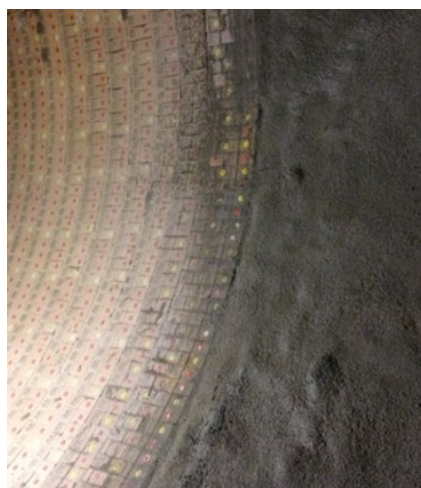
Figure 1/2: Veneering de una zona con punto caliente (fig. 1) y capa protectora en toda la circunferencia (fig. 2), ambos hornos tienen un diámetro de > 5.00 m.
