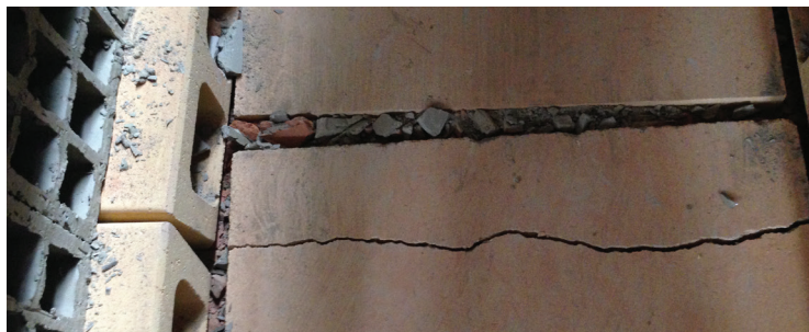
Risse durch Ansammlung von Elementen in den Fugen
